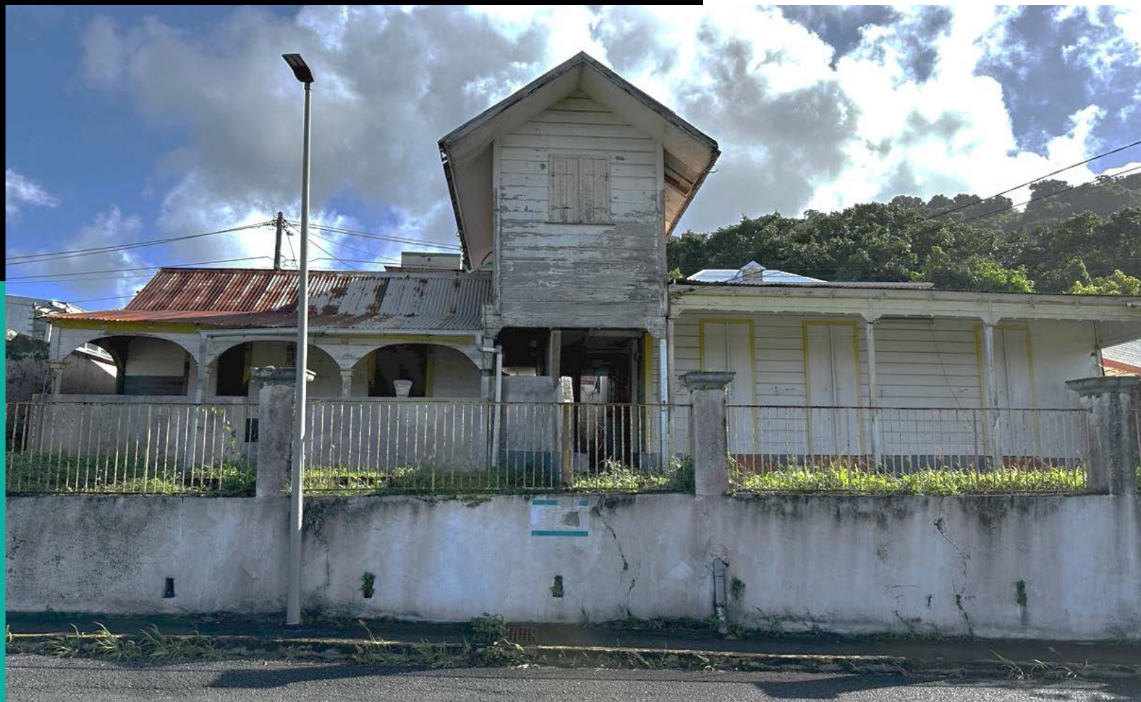
Photographie du bâtiment existant
