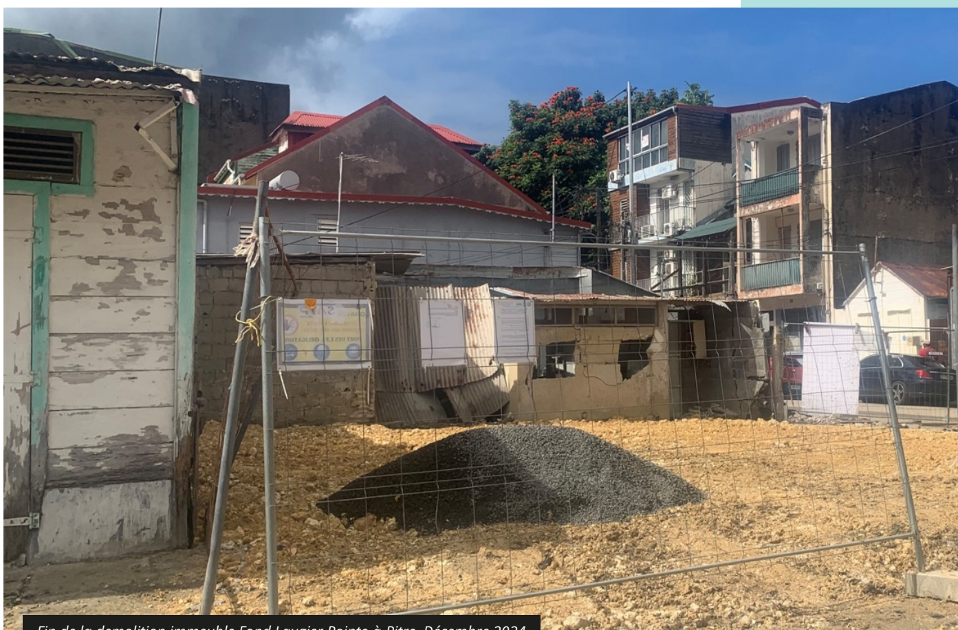
Fin de la demolition immeuble Fond Laugier Pointe-à-Pitre. Décembre 2024
