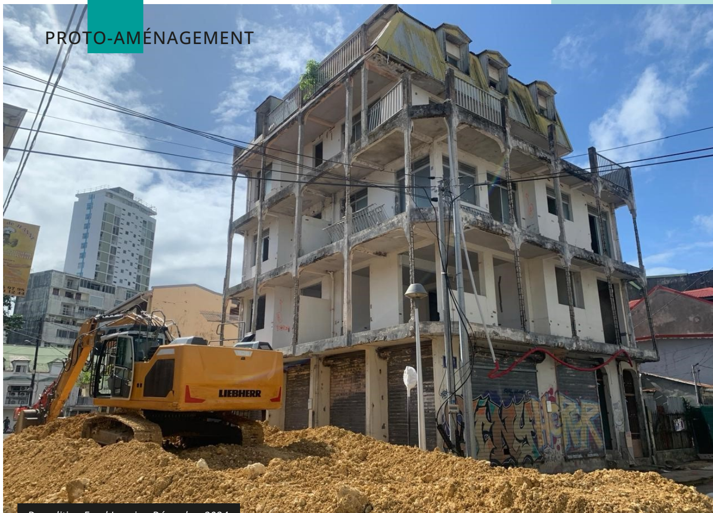
Demolition Fond Laugier. Décembre 2024
